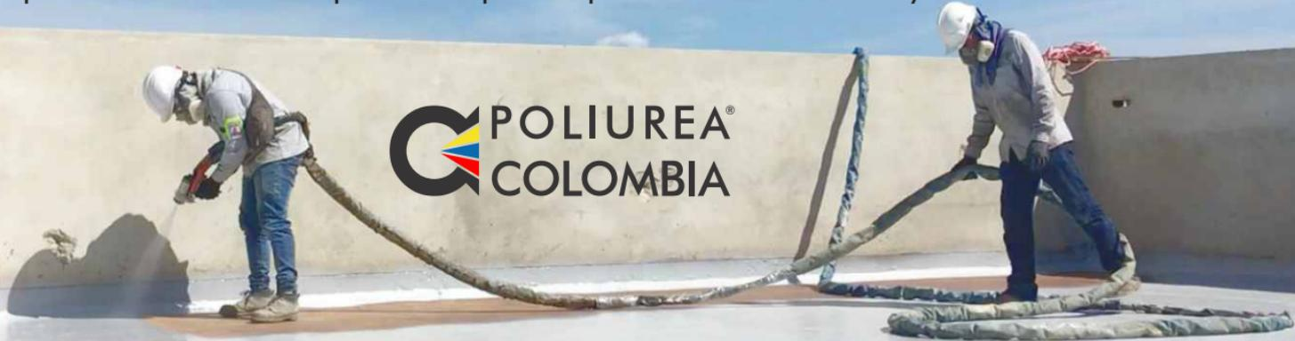
La *poliurea* es un sistema que se deriva de la reacción de un componente de isocianato con una amina; es proyectable, 100% sólido, no es dañino para el medio ambiente y protege las superficies de desgastes y de la corrosión medioambiental.
